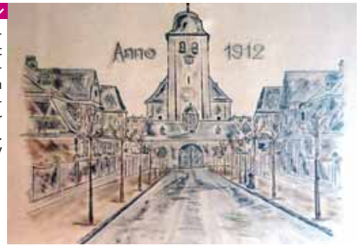
Zeichnung der historischen Ansicht der heute denkmalgeschützten Justizvollzugsanstalt Diez im Jahr der Fertigstellung. Foto: BV
