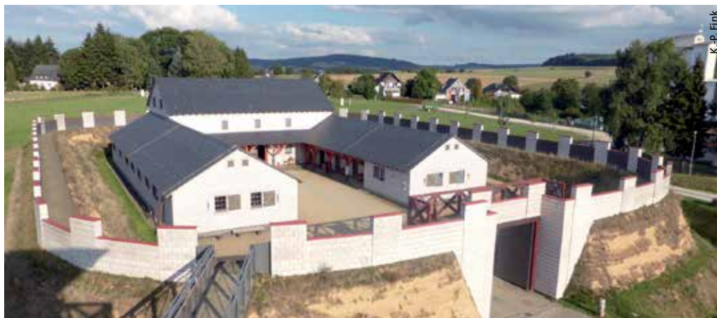
> Das Limeskastell vom Signalturm aus gesehen.
